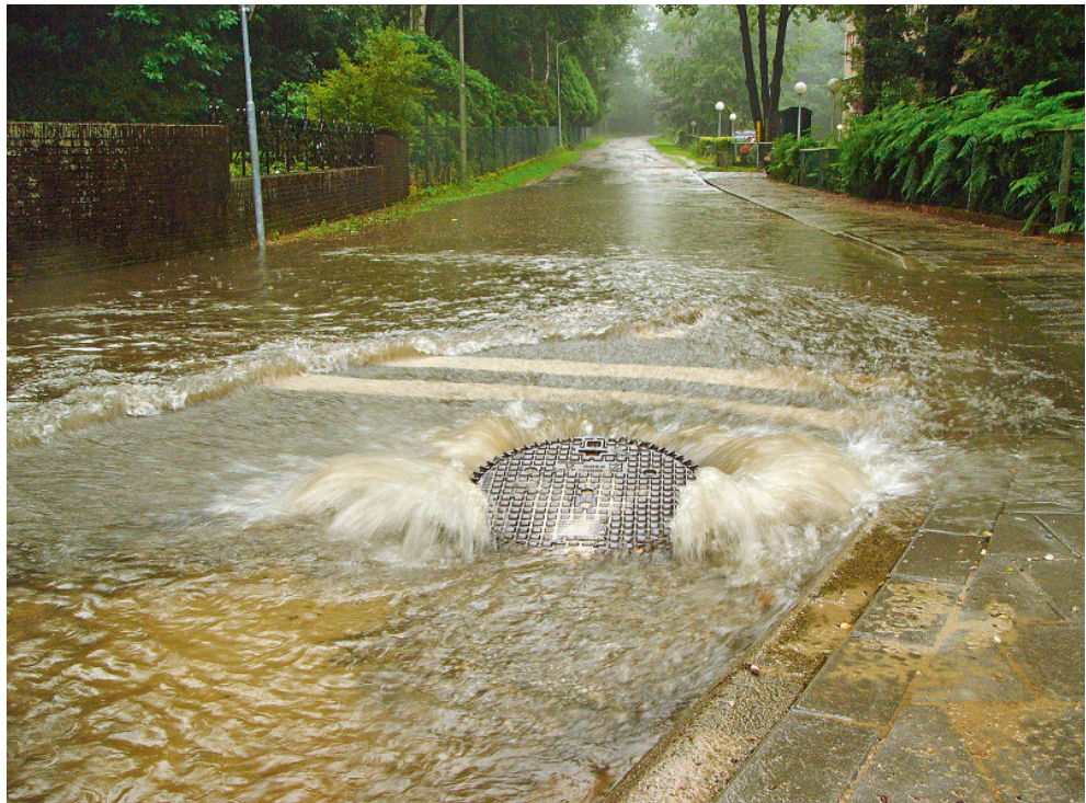
Figuur 1.1 Water op straat vanuit de gemengde riolering door hevige neerslag
