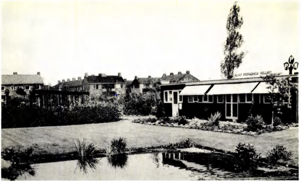
Kantoor Plant Propaganda Holland P.P.H.
