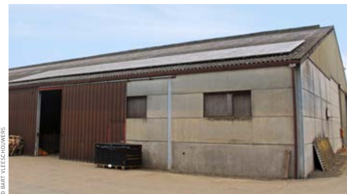
De relatief kleine installatie van Hoeve Ten Halve in Herent heeft een piekvermogen van 10 kW.
