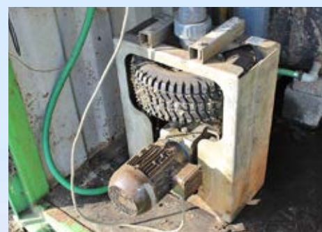
Deze balgpomp pompt de mest door de warmtewisselaar, een eigen ontwerp van Bioelectric.
