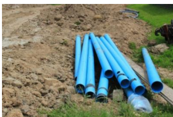
PVC buizen bronnen
