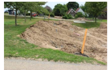
Maaiveld na plaatsing
