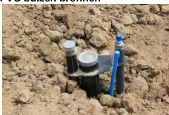
Overloop afstelstukken en peilbuis
