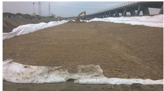
Figuur 6.3 Installeren grindkoffer bij Project Hoogwatergeul Veessen-Wapenveld, Combinatie IJsselweide (Boskalis en Van Hattum en Blankevoort)
