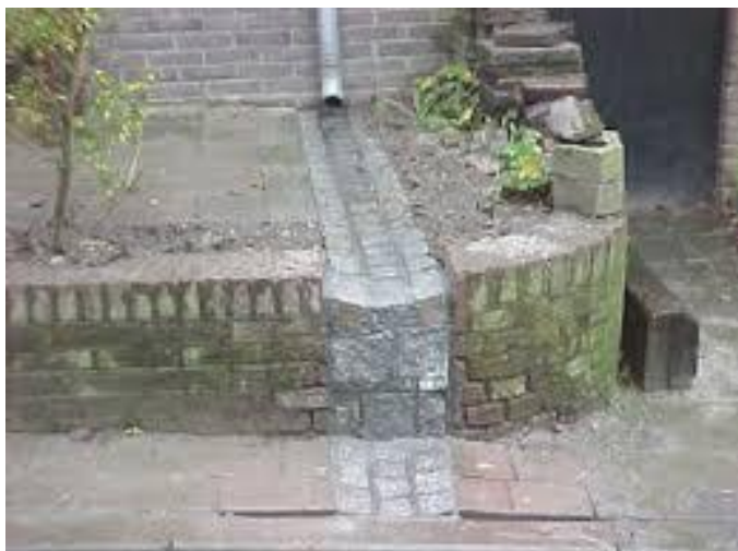
Foto 3. Een afgekoppelde regenpijp met hemelwatergoot naar de straat.
