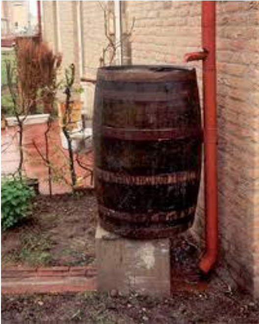
Foto 2. Afkoppelen: De regenpijp aangesloten op een regenton en een hemelwatergoot naar de straat.
