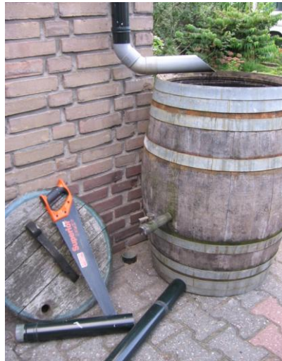
Foto 1. De situatie voor en na het afkoppelen: regenpijp doorzagen en hemelwater opvangen, hier met regenton.
