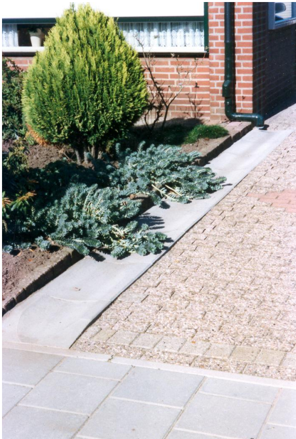
Foto 12. Hemelwaterafvoer via een betonnengoot
