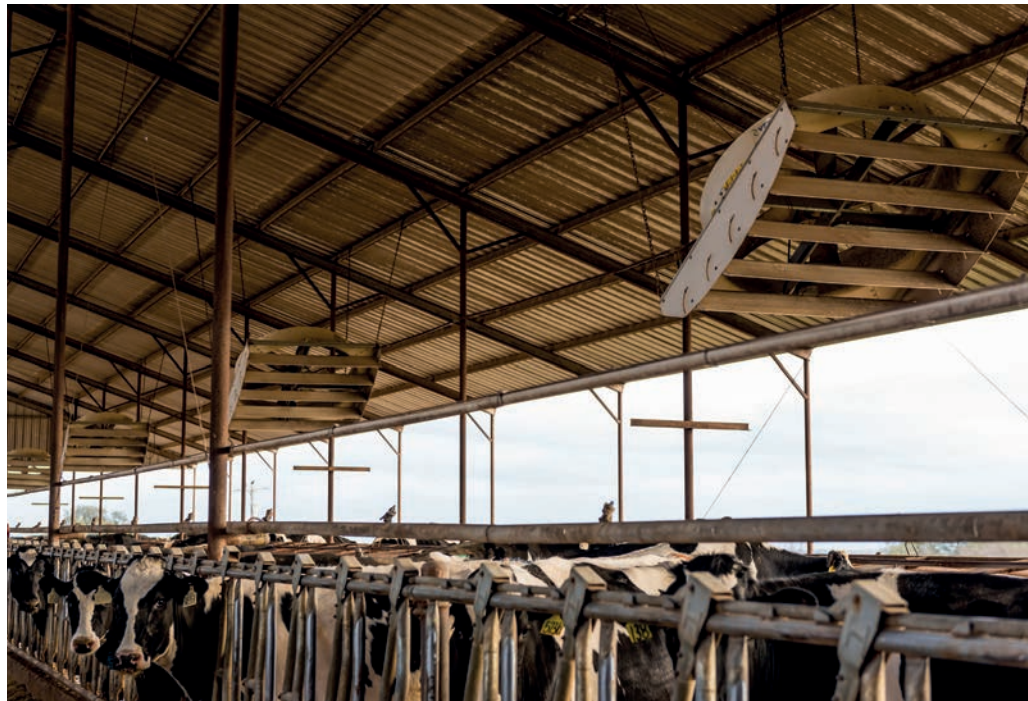
Grote ventilatoren houden het klimaat in de stal aangenaam
