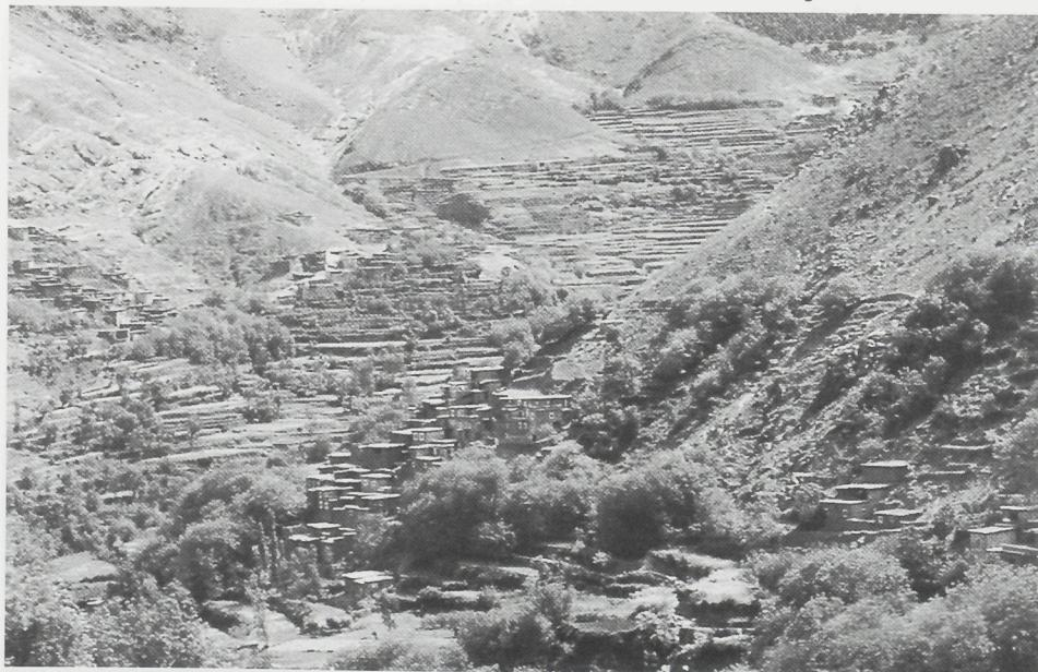
Abb. 14: Intaktes Terrassensystem von Ait Souka bei Imlil; rechts am Hang der Hauptzuleiterkanal oberhalb der Baumgruppen. Trotz massiver Schäden an den Oberhängen präsentiert sich die Bewässerungsoase in bestem kulturtechnischen Zustand.
