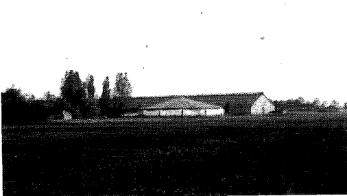
De silo met de Derco-kap.
