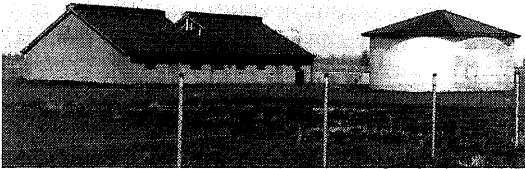
Foto: S. D. Duives-Cahuzak. De bedrijfshygiënische unit.
