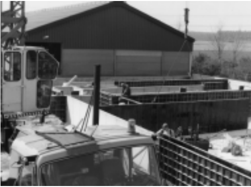
De bouw verloopt voorspoedig.
