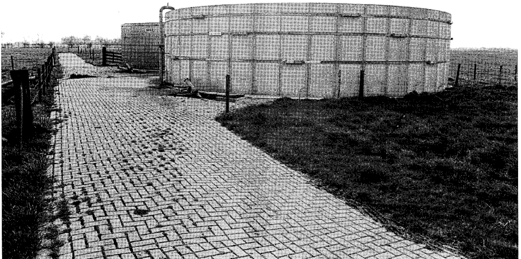
De silo's op ROC Zegveld werden afgedekt met een drijvende afdekking.
