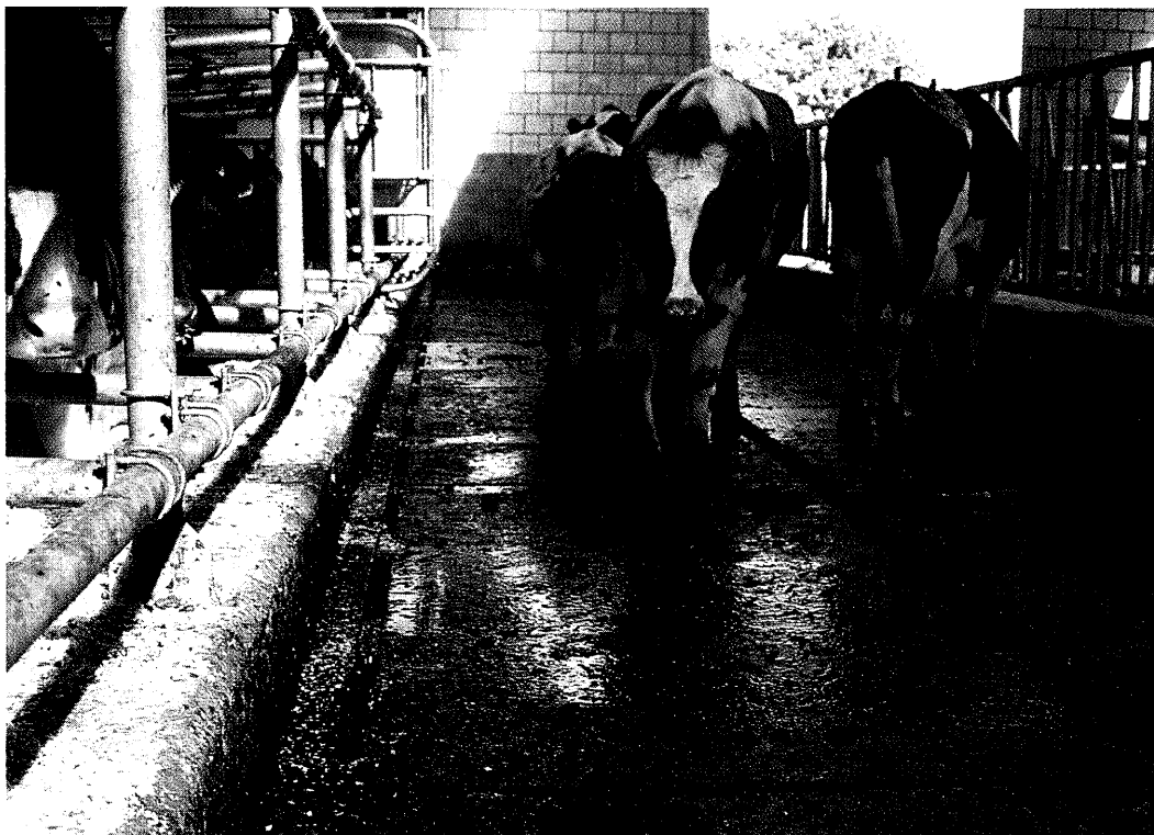
Prefab elementen met afstort voor de vaste mest.
