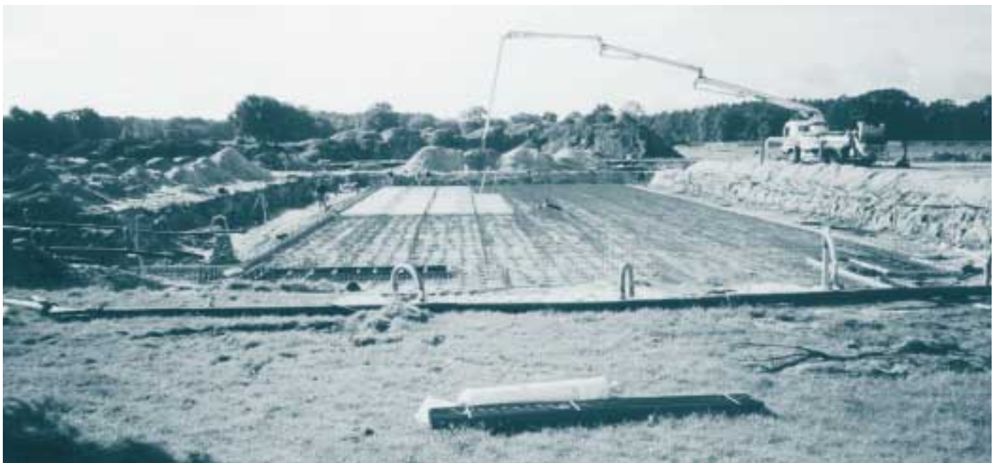
In één dag is de keldervloer van 1250 m 2 gestort!
