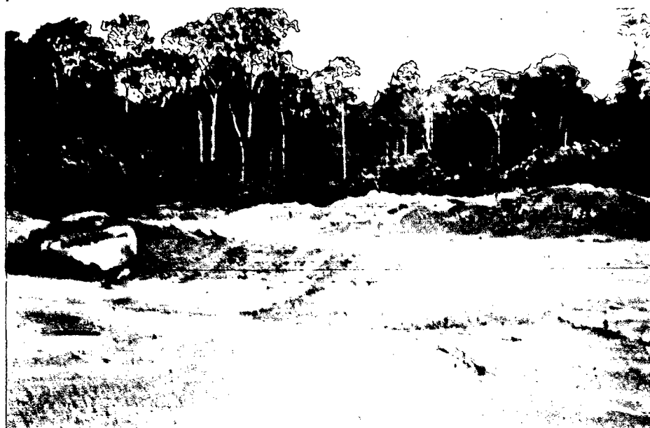
2 — Empréstimo de concreções ferruginosas. Um dos locais às margens da rodovia BR-230 (Transamazônica) onde se verifica a extração de concreções ferruginosas com aproveitamento na conservação da própria estrada. Os matacões indicam a presença de litologias ígneas do Pré-Cambriano. Folha SB.20-Z-D. Março de 1976.
