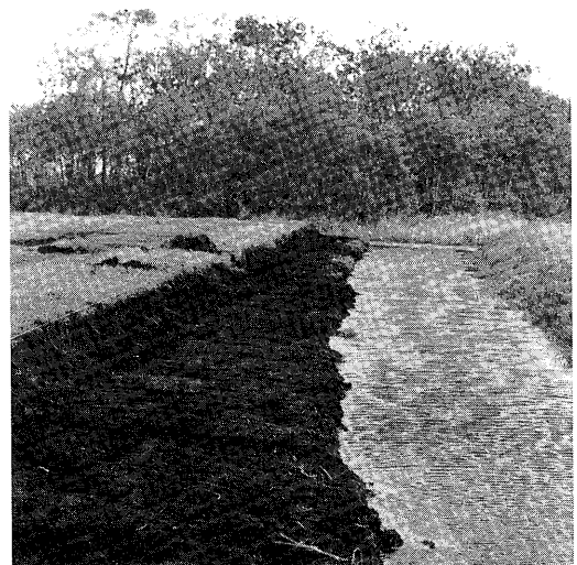
Met het aanleggen van een terras kan ook bij diepe ontwatering een strook moerasvegetatie worden gecreëerd.
