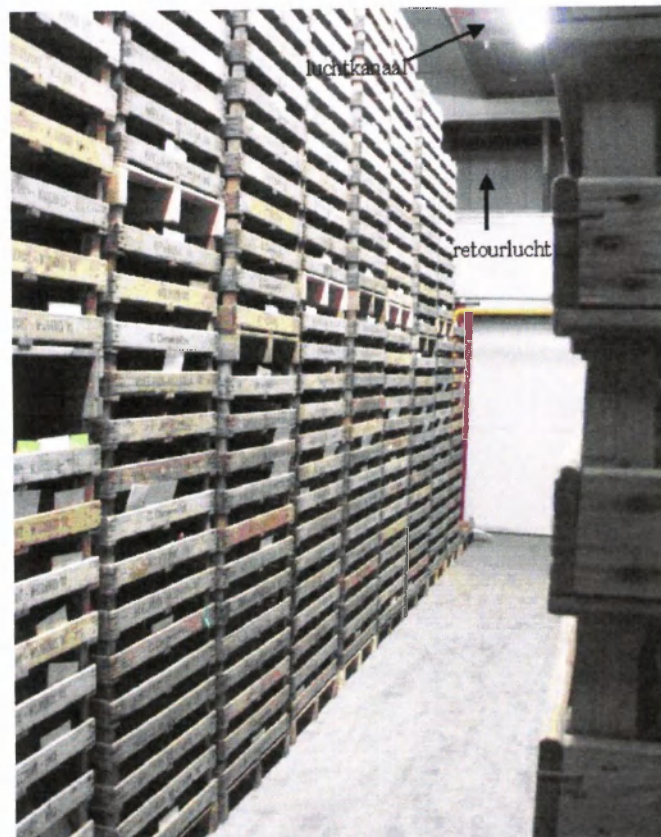
Fig. 12, retourlucht - en aanvoerluchtkanaal.
