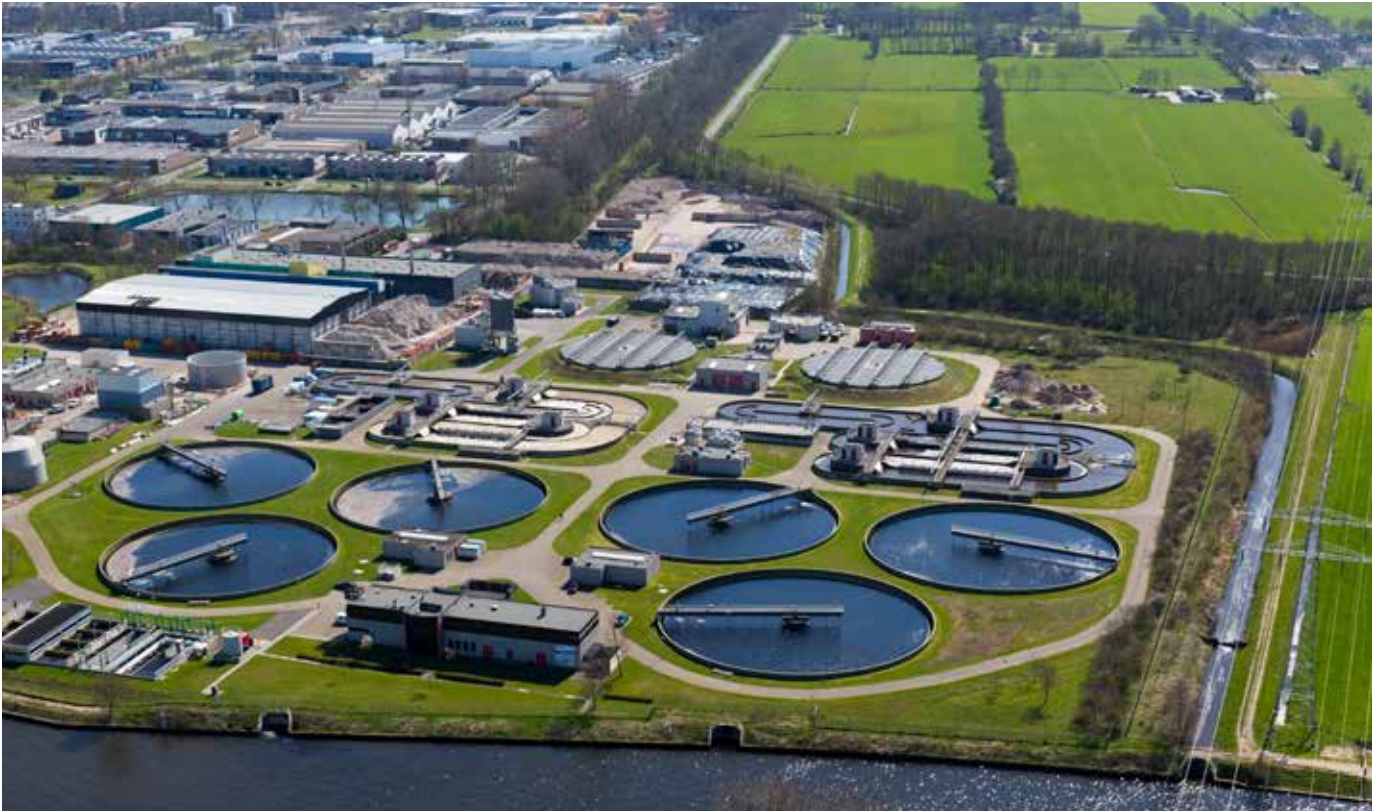
De energiefabriek van waterschap Valleij en Veluwe in Amersfoort
