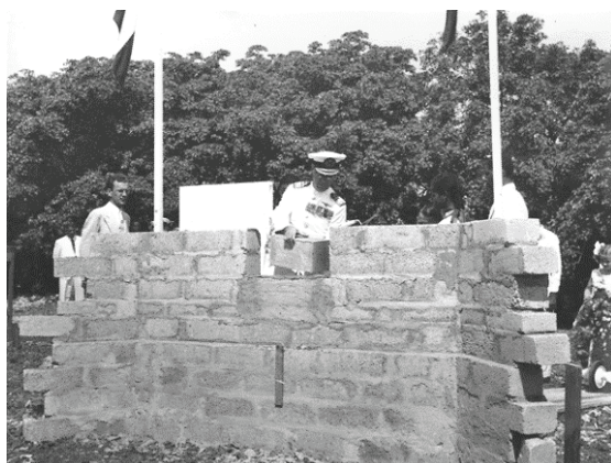
Fig. 1. Eerste steenlegging door Z.K.H. Prins Bernhard op 19 Oktober 1955.
