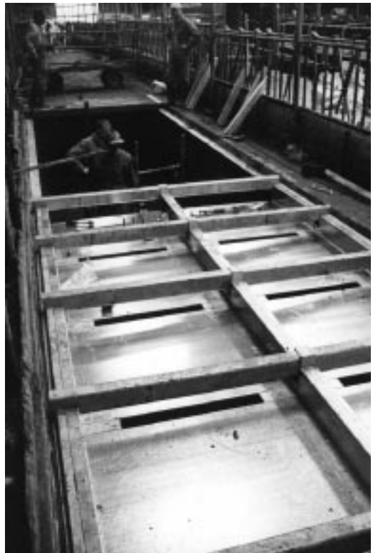
De mestkelder wordt afgesloten door bakken onder de roosters.
