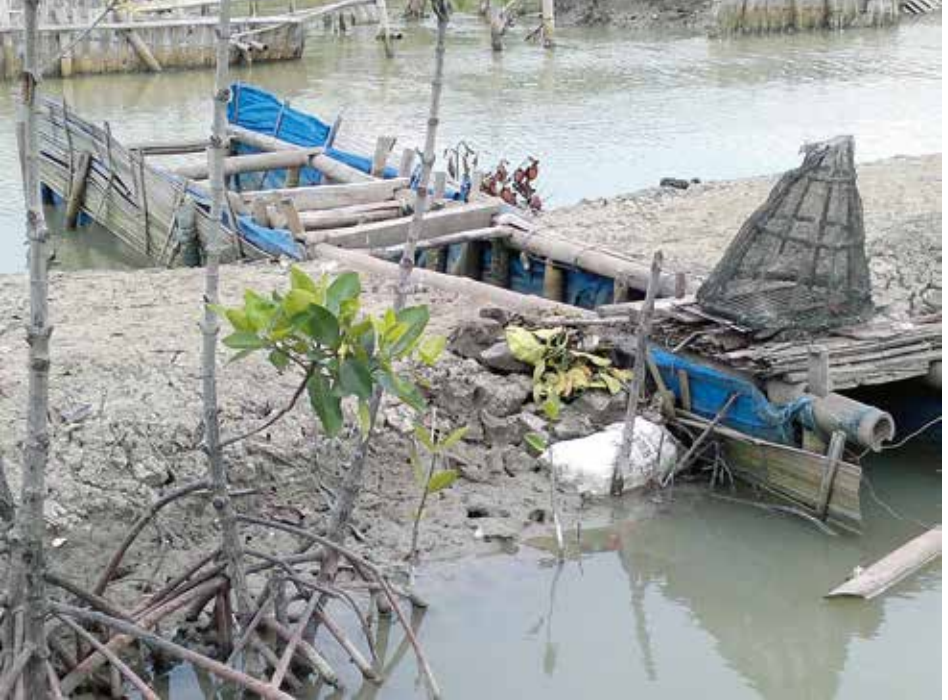
Foto 5: Vijvers hebben een sluis voor zowel inlaat als uitlaat van water.
