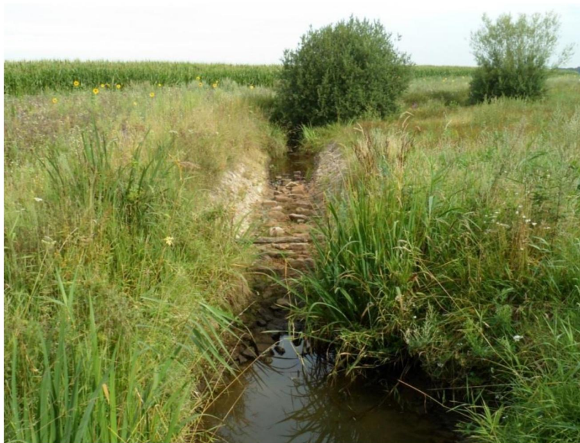
Figuur 4.16. In augustus 2015 stroomde er geen water over helling vispassage Riels Hoefke.
