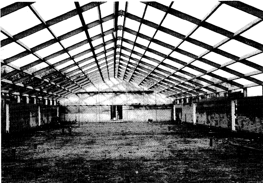
Foto: Nieuwe stal in aanbouw
