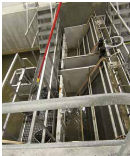
De barrière in het uitgaande water die voorkomt dat eventueel ontsnapte vis de kwekerij kan verlaten.
