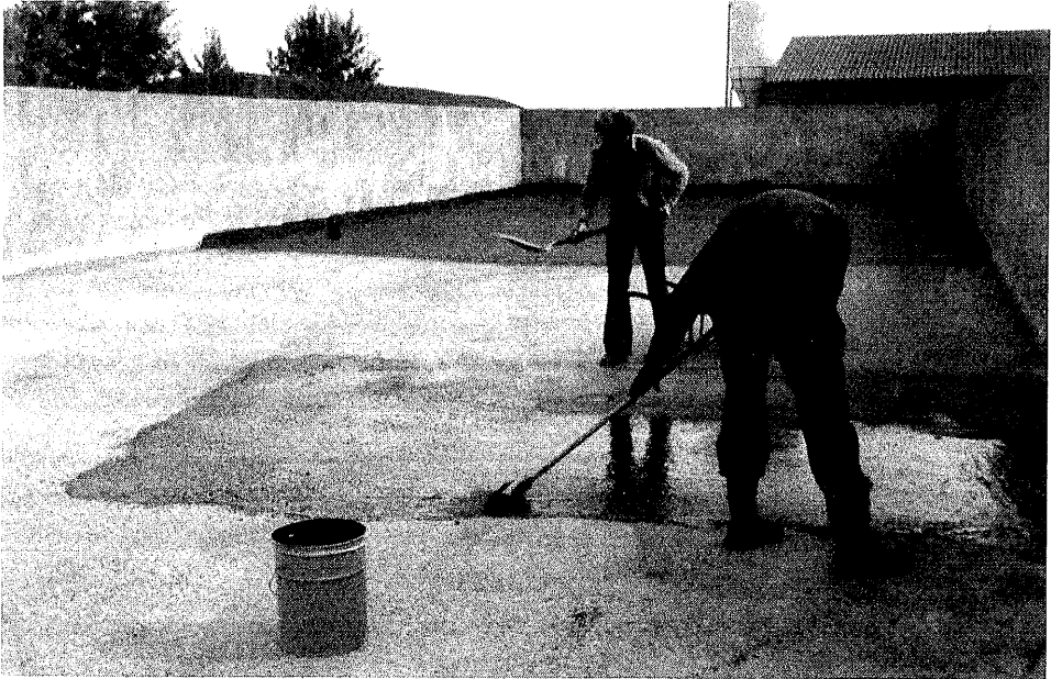
Het verdelen van de uitgegoten Elastofalt met een zachte bezem en het afstrooien met porfier (fijne steenslag). Op de achtergrond de vakken met skimcoat. Dividing the poured out Elastofalt with a soft broom and finishing it with porphyry (fine stone chip-pings). In the background the experimental parts with skimcoat.
