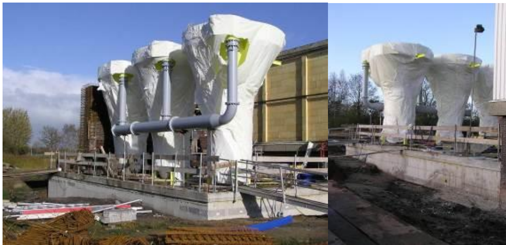
2.2.6 Inbouw van ingepakte pelletontharders op een productielocatie (foto's Vitens).
