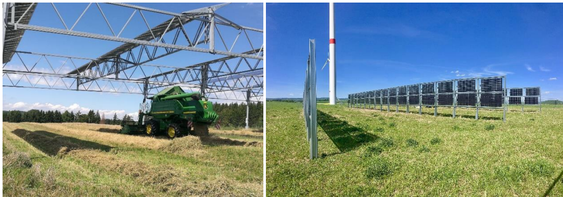
Figuur 6. Voorbeeld van een zonnepark hoog boven de grond waardoor landbouw onder de stellingen mogelijk blijft (links). Voorbeeld van bifaciale panelen (rechts) die eveneens landbouw tussen rijen panelen mogelijk maakt (bron: https://de.wikipedia.org/wiki/Photovoltaik-Freifl%C3%A4chenanlage#Agrophotovoltaik,_Agrovoltaik ).
