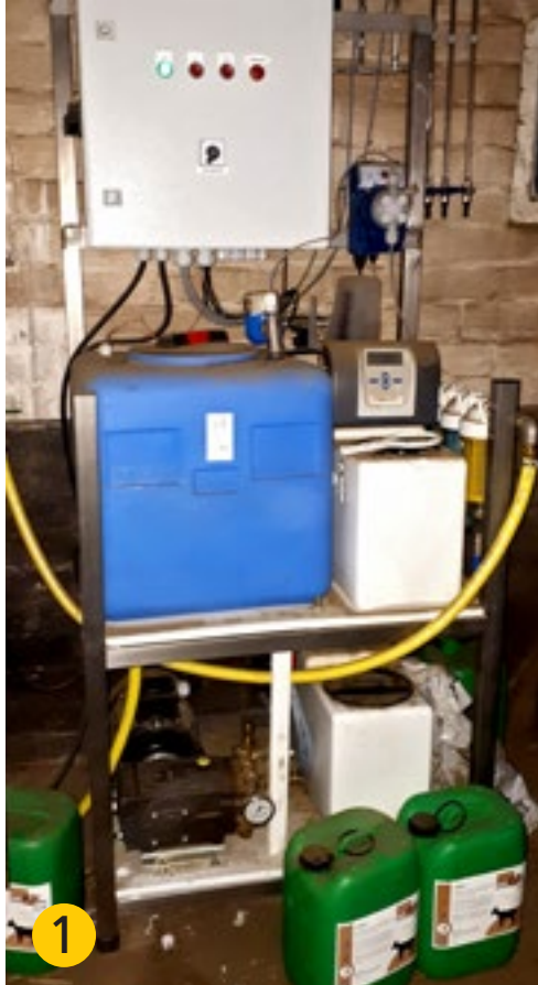
1. De pomp die zorgt voor automatische verneveling in de stal. 2. en 3. Ook in de lammerenafdeling en in de opfokstal heeft Ad Bink het vernevelsysteem geïnstalleerd. 4. Ad Bink bekijkt zelf ook af en toe het ammoniakgehalte in de stal.
