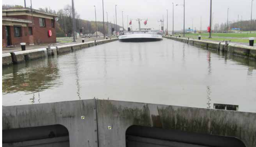
In het Albertkanaal zijn zes sluiscomplexen aanwezig die toelaten schepen tot 12.000 ton te schutten.
