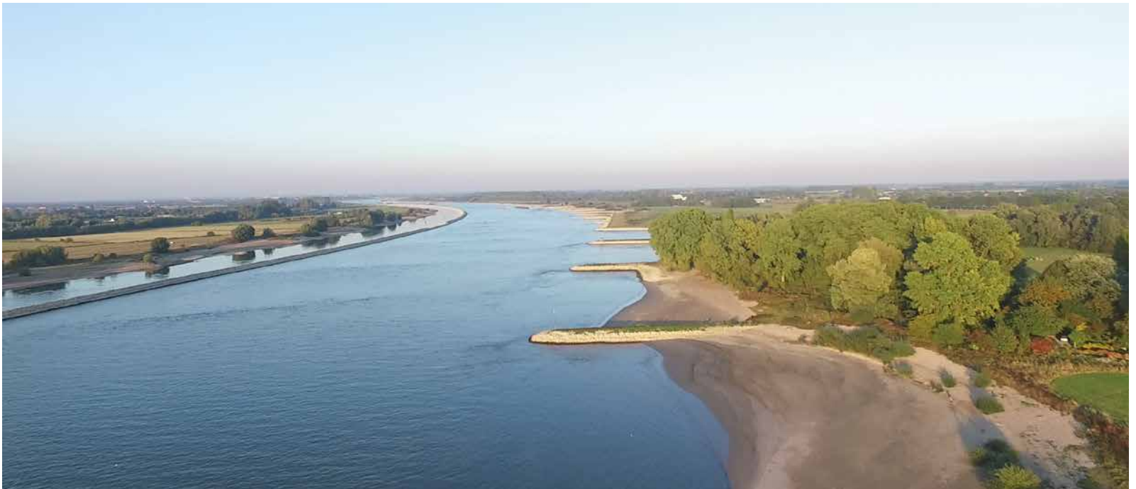
In de Waal bij Wamel zijn de kribben vervangen door een langsdam (linkerkant foto) en biedt de nieuwe oevergeul kansen voor populatieherstel van inheemse rivierissen terwijl exoten minder domineren.
