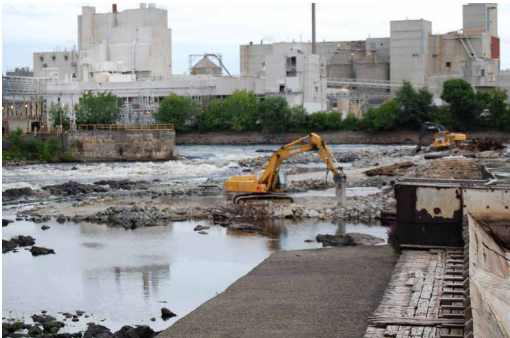
De waterkrachtcentrales in de rivier werden aangekocht en vervolgens uit de rivier verwijderd.
