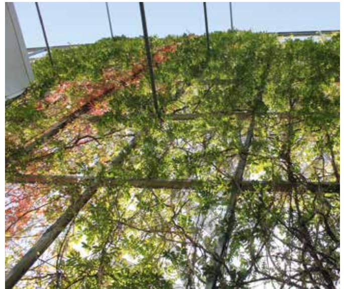
De tussenruimte tussen de glazen en de groene gevel van 4 m waardoor de planten voldoende licht ontvangen aan de binnenkant en ventilatie zorgt voor extra verkoeling.
