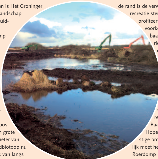
Werkzaamheden Zuidlaardermeer (foto's: Michel Krol)
