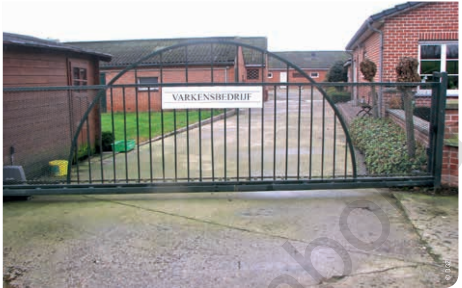
Het terrein wordt afgesloten met een poort. Maak duidelijk dat toegang tot het bedrijf verboden is voor onbevoegden.
