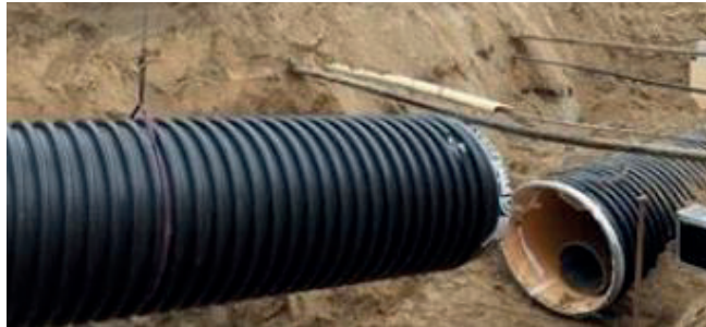
FIGUUR 5 AANLEG FRANK BUIS BIJ VELLESAN COLLEGE
