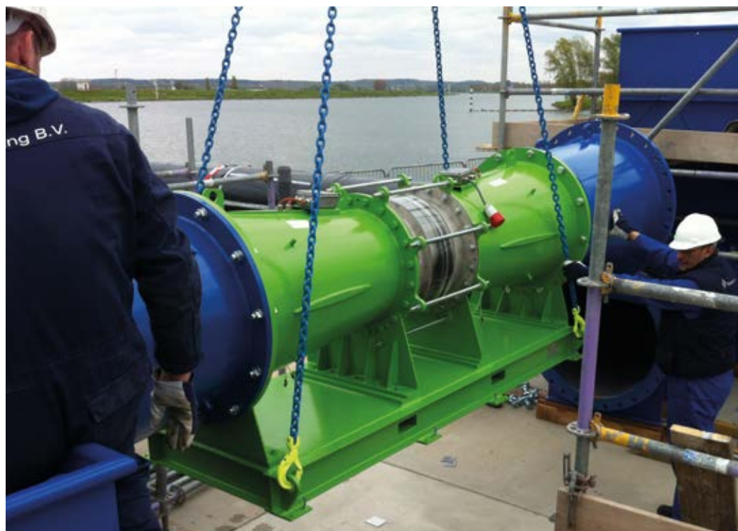
De centrale bij Linne zal voorzien worden van een visvriendelijke PFN turbine.
