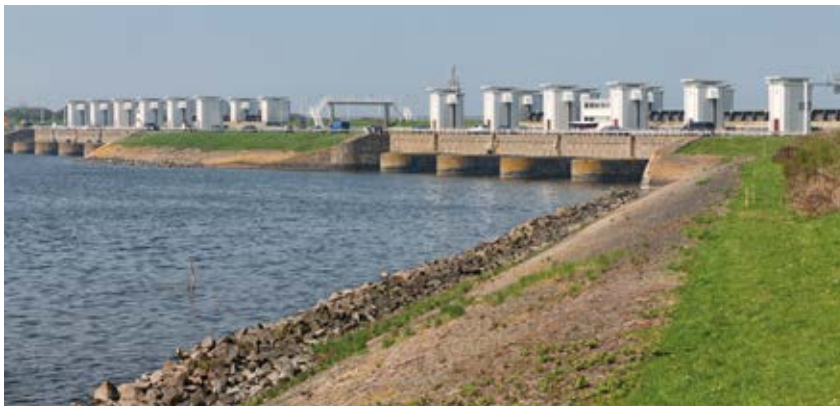
De Afsluitdijk is misschien wel het beste voorbeeld van het spanningsveld tussen investeringen in energie uit waterkracht en investeringen in vismigratie.
