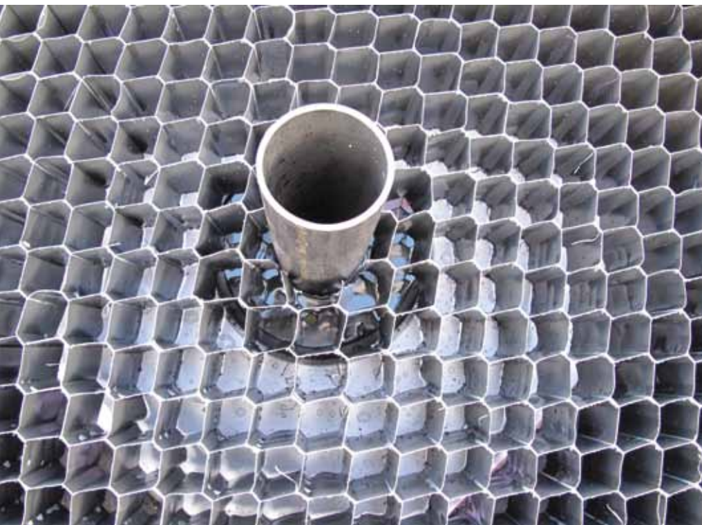
Overtollig water kan tot 24 uur op het dak worden vastgehouden voordat het op het riool wordt geloosd.
