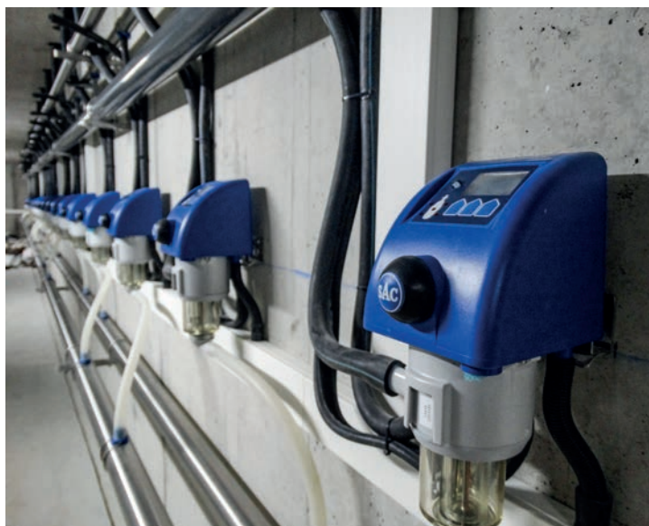
De 'subway' vereenvoudigt het onderhoud aan de melkapparatuur
