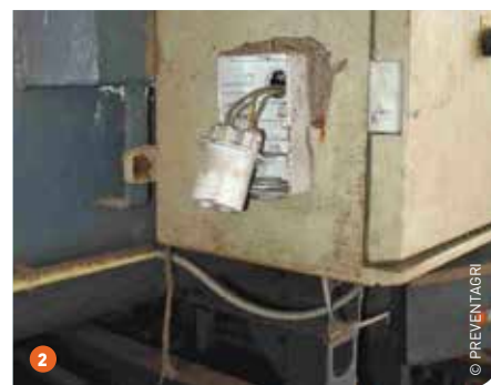
1 Zorg voor een goed afgesloten elektriciteitskast die stofvrij is en waarbij de kabels geen gebreken vertonen, zoals op foto 2
