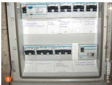
1 Zorg voor een goed afgesloten elektriciteitskast die stofvrij is en waarbij de kabels geen gebreken vertonen, zoals op foto 2
