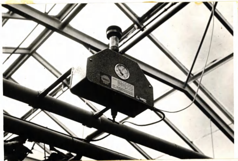
8 Pneumatische mengklepregeling
