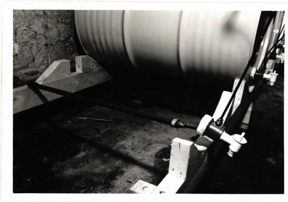
Foto 1. Neg.nr. 22750-8 Geperforeerde PVC-pijp om het opgslagen gietwater te aërerem.
