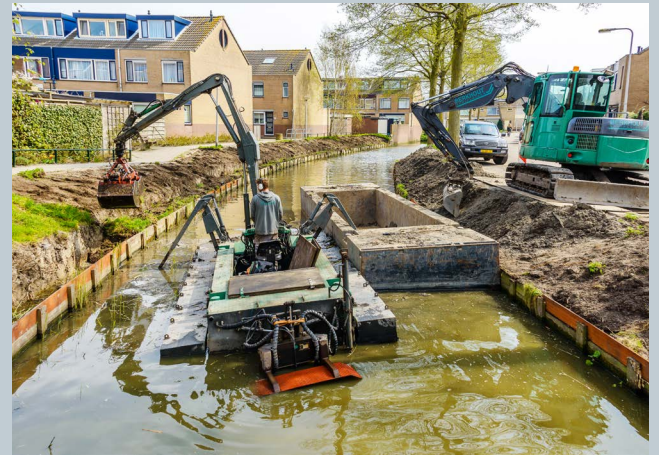
Deels vanaf het water en deels vanaf de wal wordt deze oever met minimale overlast voor omwonenden bijgewerkt.
