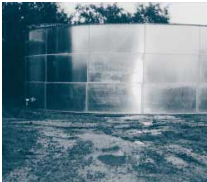
Biogasinstallatie op Praktijkcentrum Sterksel om uit varkensdrijfmest biogas te produceren
