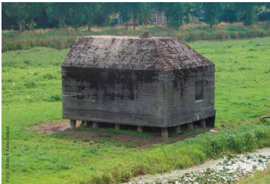
Door bodemdaling ten gevolge van inklinking van het veen zijn de fundamente van deze bunker uit 1940 bloot komen te liggen.
