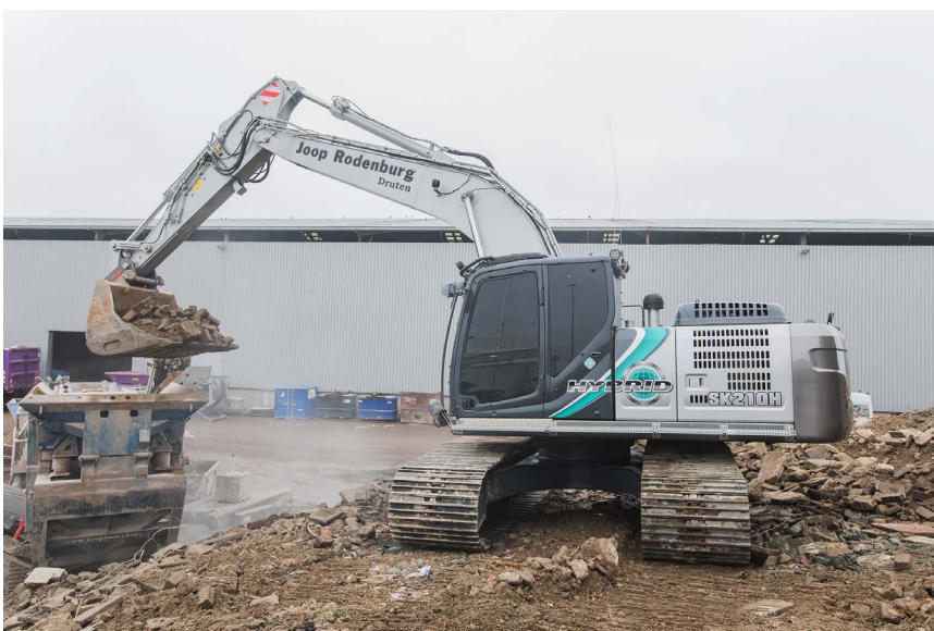
Bij Joop Rodenburg Sloopwerken en Puinrecycling staat de machine voornamelijk bij de puinbreker. De machinisten vinden hem vooral in de cabine heerlijk stil.
