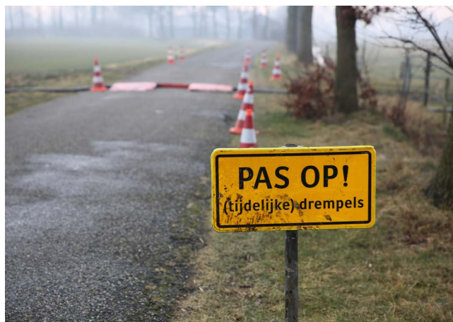
De slangbrug over de weg, in een oogwenk neergelegd en duidelijk gemarkeerd met borden en pylonen.
