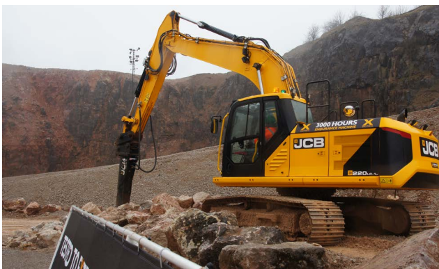
In de testgroeve van JCB draait een machine die al meer dan 3000 uur heeft gewerkt met een sloophamer.
