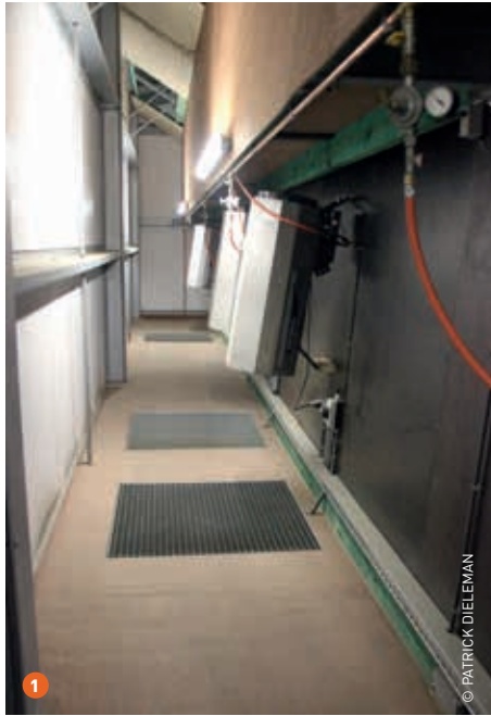
1 Voor het bewaren van de uien zijn kachels standby. De ventilatoren onder de roosters zijn EC-ventilatoren, met het oog op energiebesparing en in de hoop op een VLIF-tegemoetkoming van 30%.
