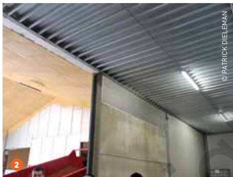
1 Een beeld in de drukgang. Rechts de drukwand met enveloppesysteem, waarbij de lucht via afsluitbare kleppen in de ruimte tussen de palloren geblazen wordt. 2 De passerelle tussen de twee loodsden in bedekt met steeldeckplaten, met daarboven isolatie en een dakdichting. 3 De nieuwe loods behoefde door de kistenbewaring geen drukvaste wanden, wat een lichte constructie toeliet. Bemerkt onderaan de geïsoleerde betonplaat en de condensor van de koelinstallatie.
