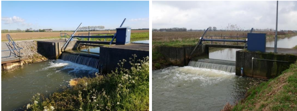
Figuur 11 - links: Stuw Bedelbrug, rechts: Stuw Kemperman
