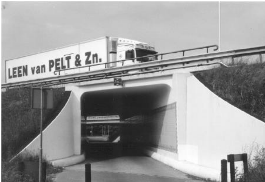
Figuur 4 Fietstunnel Amersfoort (bron: L.M.v/d Berg)
